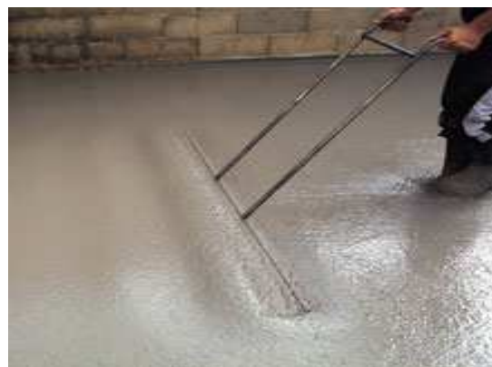
Figure 1 : Egalisation d'une chape après sa mise en place avec ORKE NIV HP
